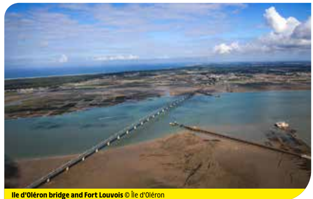
Île d'Oléron bridge and Fort Louvois © Île d'Oléron
