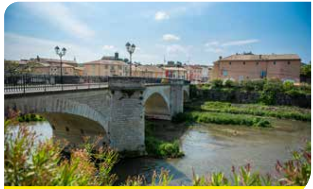
Colonel de Chabrières Bridge, Bollène ©Morgan Petitimberty
